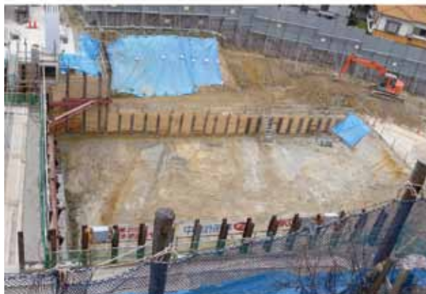
「西棟」(10 層) 基礎部分 地表に縞が現れています。
