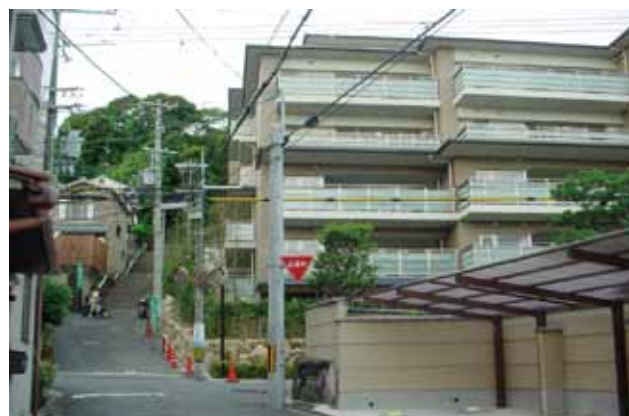
図4 マンション改正後の現場景観
