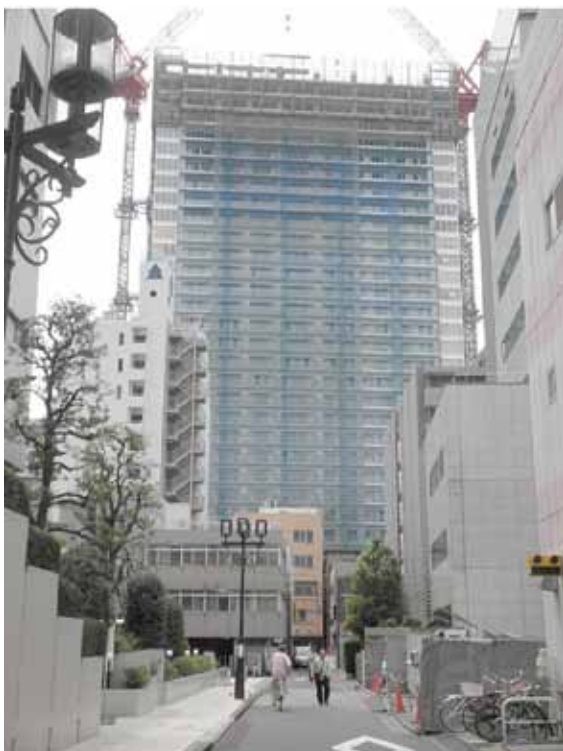
建設中の本計画建物 完成時にはこれにさらに 10 階が上乘せされる。
