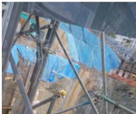
「南棟」(14 層) 基礎部分 掘削した基礎穴の側面に縦縞。
