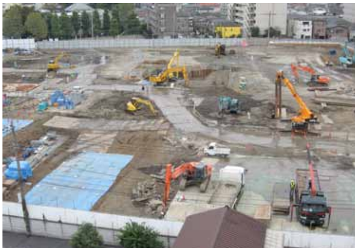
（土壌汚染改良工事中）
