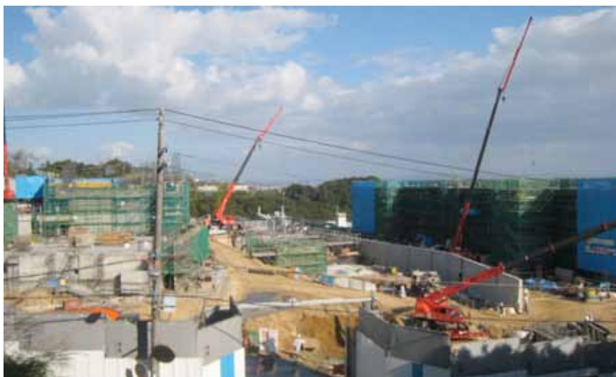
▼ After (同地点より撮影) 2012 年 10 月 29 日撮影
