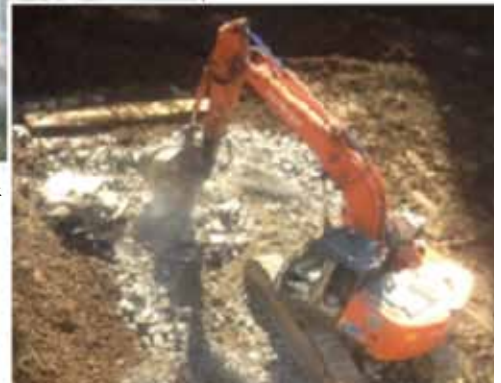
地盤改良材の混入風景
