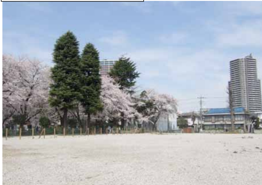
写真上＝青年の家解体後の更地に再生砕石敷設
