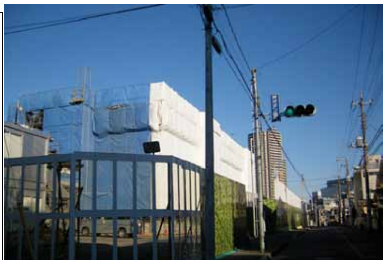
写真上＝建設中の日赤埼玉県支部社屋（2011.1.10）
