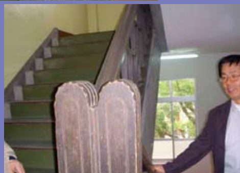
大名小学校階段 の手すり
