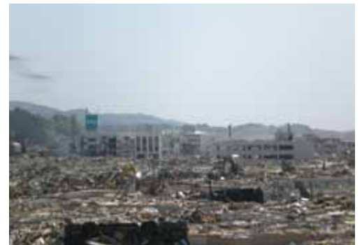
視界の全てが破壊され、流された
